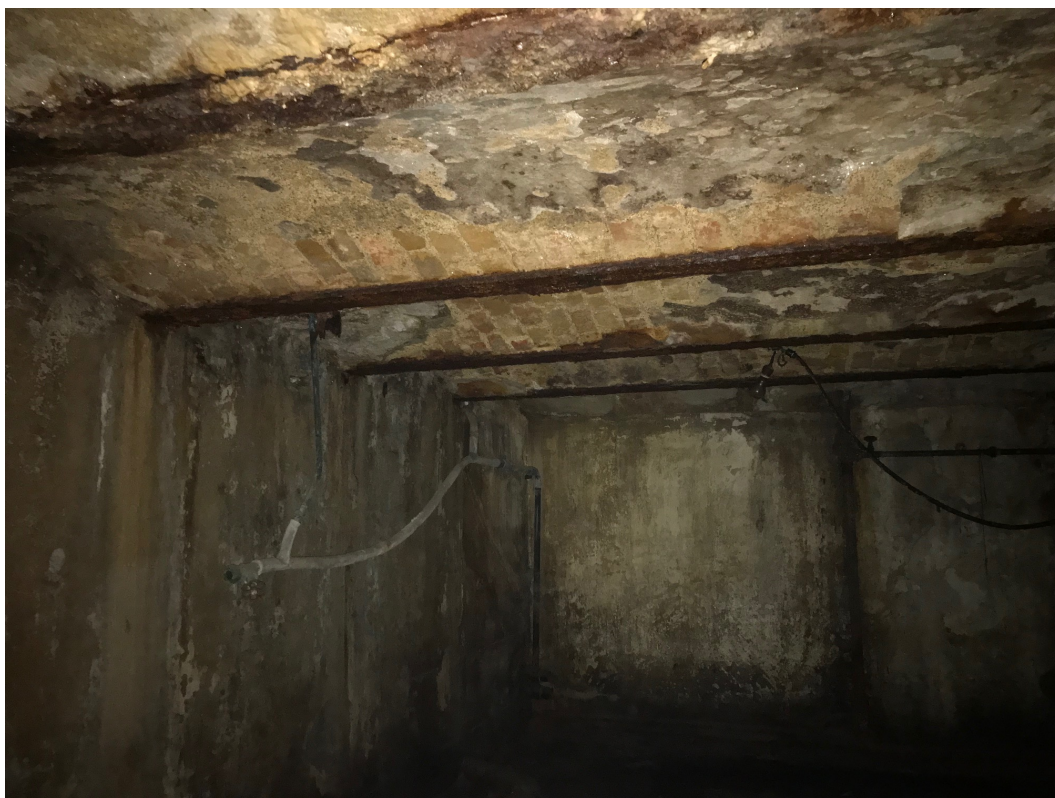
Foto č. 10 - Havarijní stav konstrukcí kleneb a ocelových nosníků v I. suterénu
