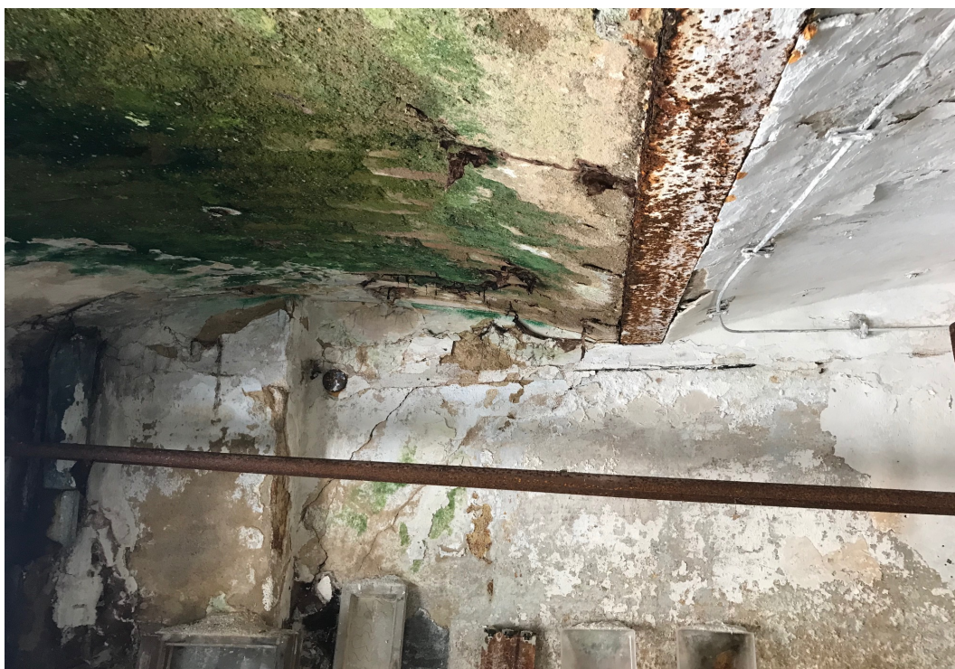
Foto č. 03 – Lokální porušení zdiva klenby ve 2.NP, šikmé trhliny ve zdivu
