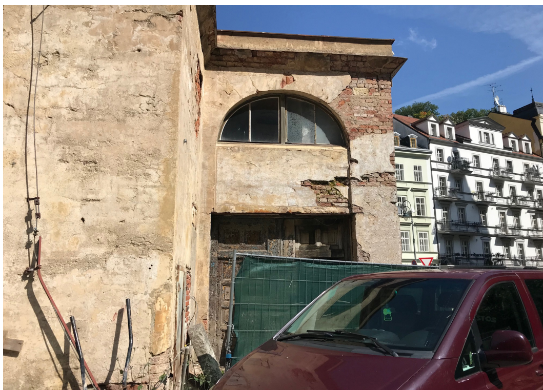
Foto č. 15 – mrazové poškození omítek, zdiva a říms jižní ustupující fasády – 09/2021
