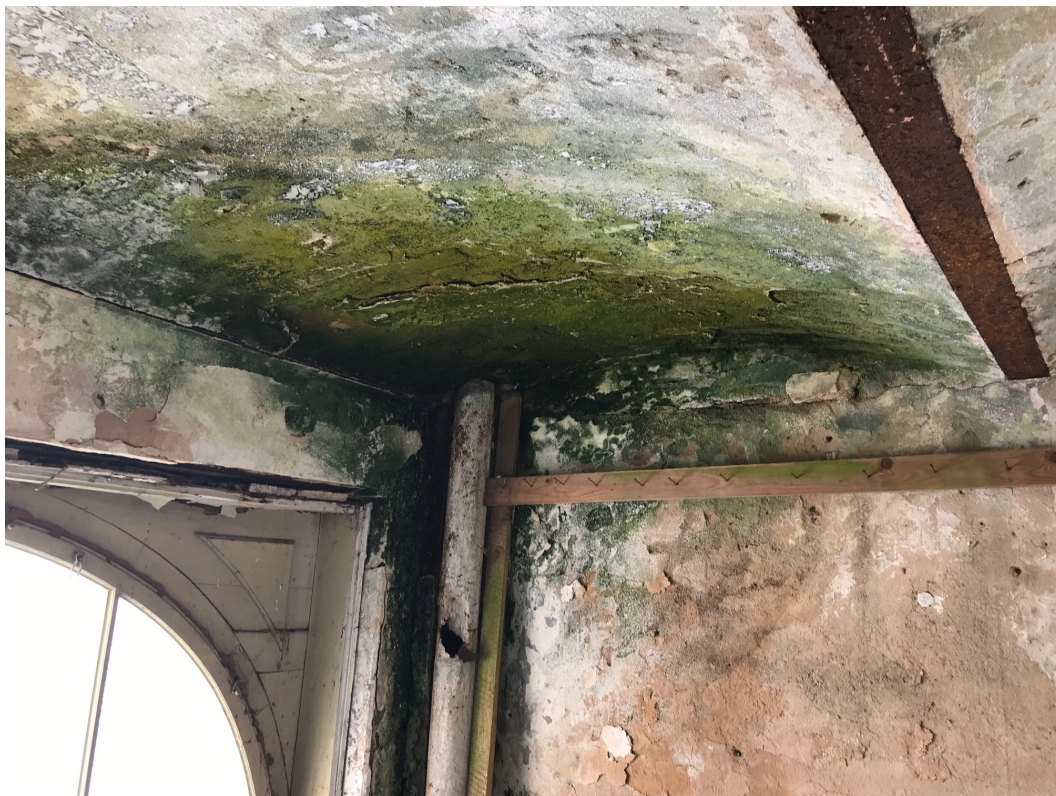
Foto č. 01 – zatékání do budovy ve 2.NP, stav 09/2021
