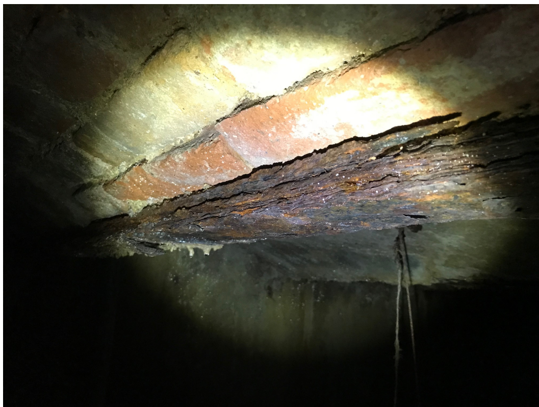
Foto č. 12 – Detail masivního korozivního poškození nosníku klenby v I. Suterénu
