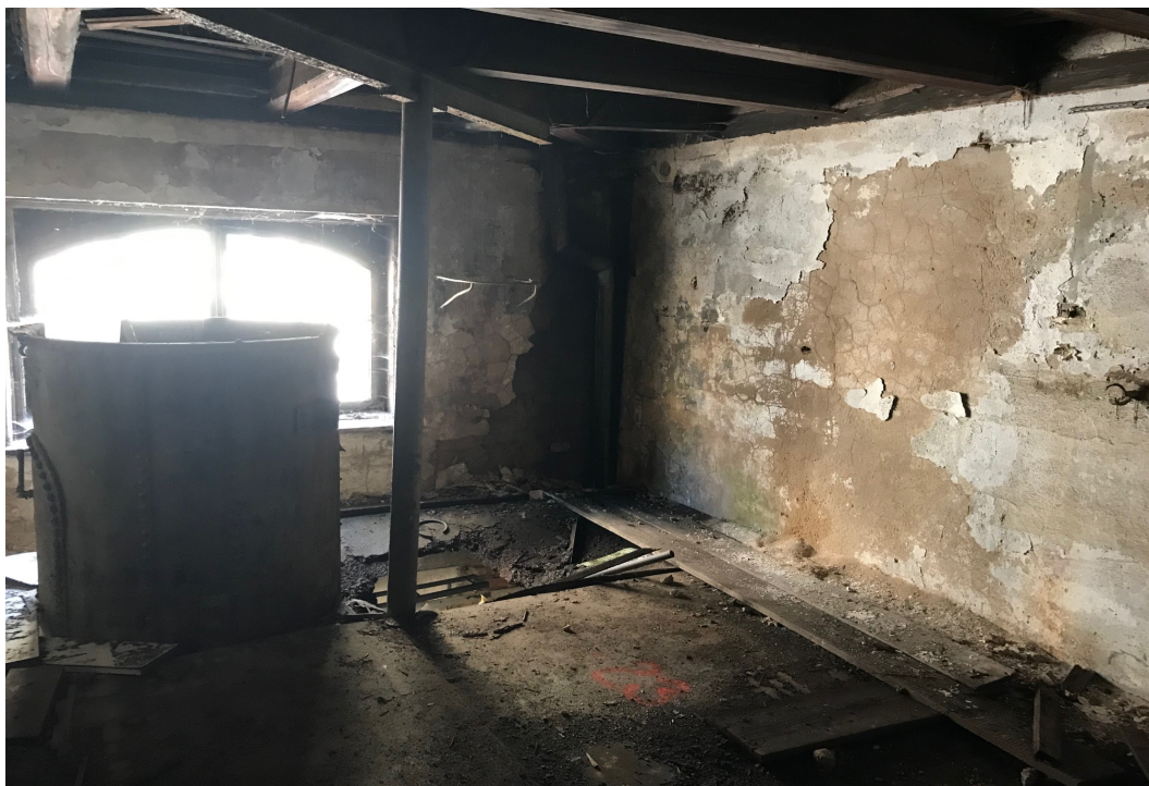
Foto č.06 – Zatékání a destrukce bednění mezistropu v místech dřevěného krovu zastřešení – SV nároží budovy
